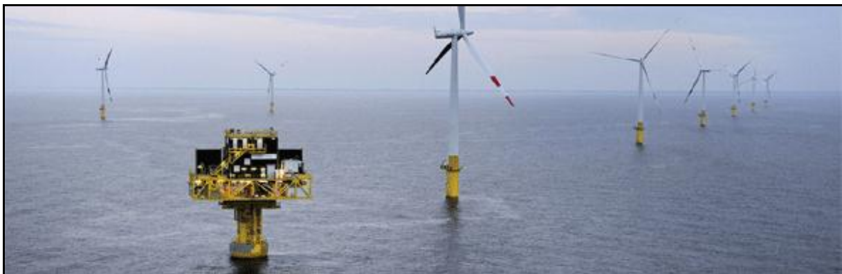
Abb. 74: Deutschlands erster kommerzieller Offshore-Windpark in der Ostsee - OWP „Baltic 1“ (Quelle: www.enbw.com )
